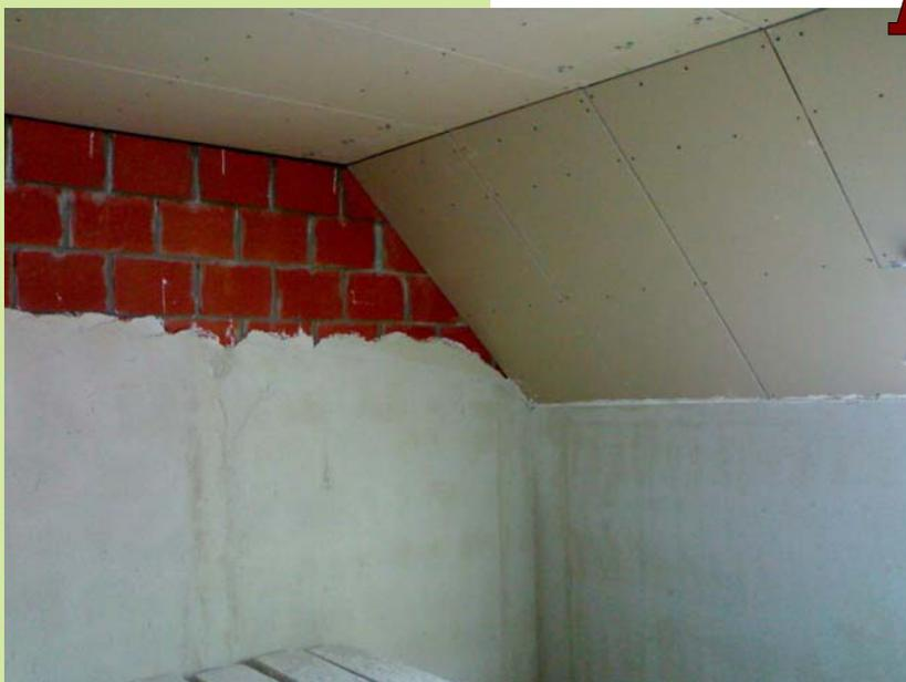
**A**u rez-de-chaussée, il y a le plâtrage de tous les murs intérieurs et extérieurs, à l'exception du garage et de la chaufferie où la maçonnerie est rejointoyée.
