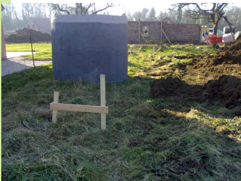
**L**a paroi de la maçonnerie qui est en contact avec les terres, est protégée contre l'humidité, sur toute sa surface, au moyen d'un enduit à base de ciment recouvert de 2 couches d'émulsion bitumineuse.
